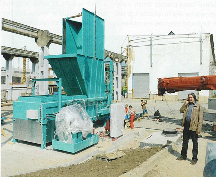
Adolf Moudr, jednatel společnosti MOUDER, s. r. o., jež dodala do překladiště technologický celek Husmann, dohlíží na jeho instalaci
